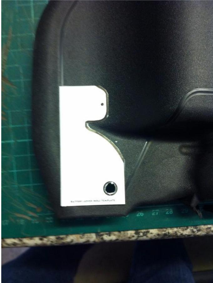
Jetzt mit einem spitzen Gegenstand (z.B. kleiner Schraubendreher das Bohrloch markieren und mit einem 2-3 mm Bohrer vorbohren)
